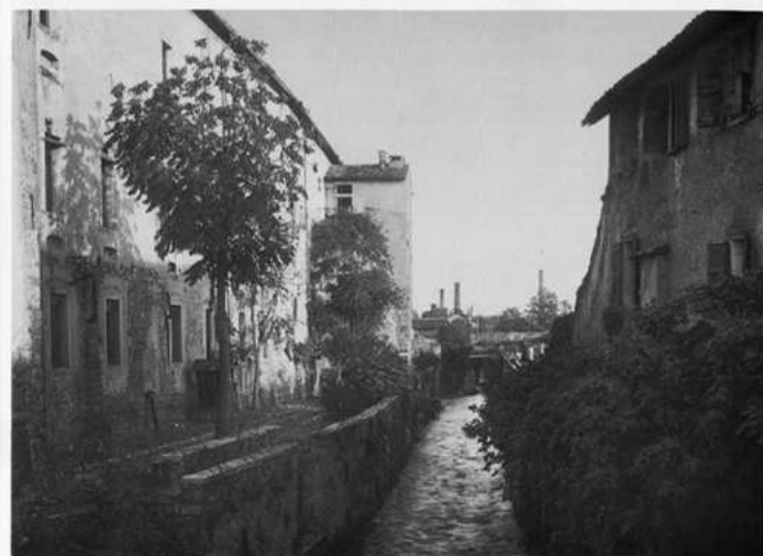
Caserma Pallone B, lato sud su Adigetto
