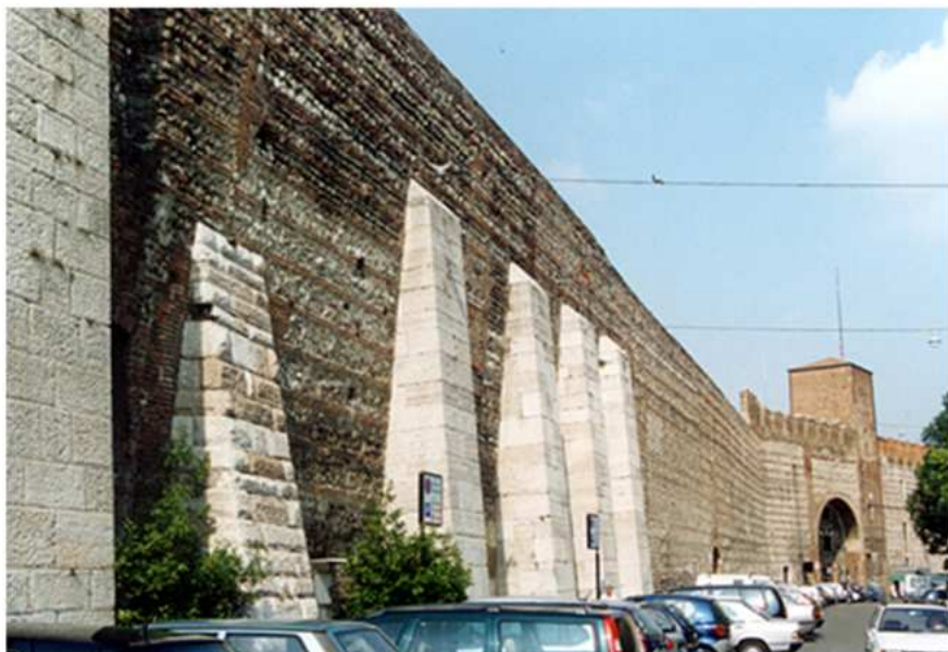
Caserma Pallone A. Cinta muraria con barbacani di sostegno
