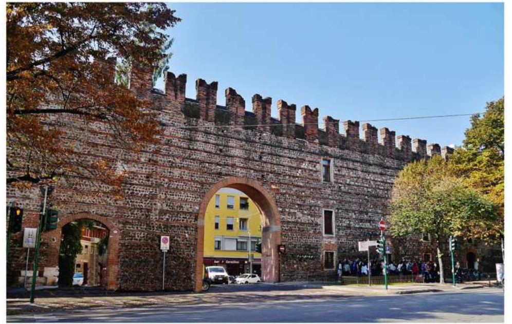
Fornice su Stradone Maffei
